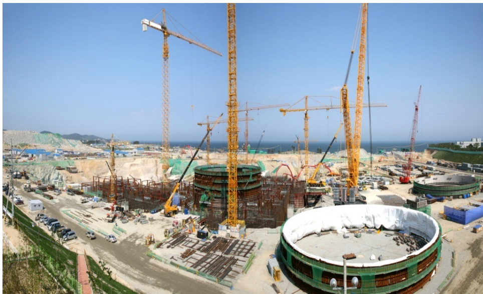
図表 16：新古里3・4でのAPR1400の建設風景
