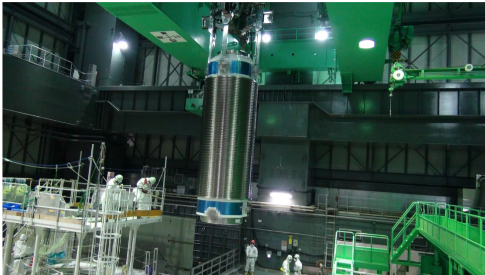
4号機原子炉建屋からのキャスク移動
