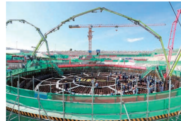
中国で始まった「玲龍一号」の実証炉建設工事(7/13) ©CNNC
