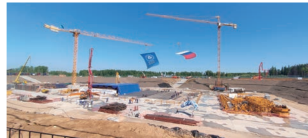
ロシアのSCCで始まった「BREST-300」の建設工事(6/8) ©TVEL
