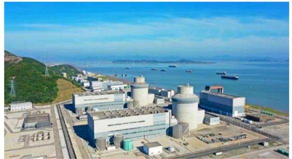
AP1000は受動的安全システムを特徴とし、外部電源喪失時でも自然循環による冷却が可能で、安全性が高い設計となっている。しかし、三門原発の建設は設計の変更や部品の遅延により当初計画より遅れた。運転開始後はAP1000の信頼性が確認され、中国では改良型のCAP1000の開発や、さらに大型化したCAP1400の計画が進められている。三門原発の成功は、中国の次世代原子炉開発と世界の原子力技術の発展に大きな影響を与えている。
