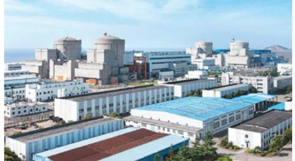
秦山原発は複数の原子炉を有する大規模な発電所であり、第一期 (秦山1号機)、第二期 (秦山2号機群)、第三期 (秦山3号機群) に分かれている。第一期は300MWeのPWRで、中国独自の設計が採用された。第二期は改良型PWR (CNP-600) で、各炉650MWeの出力を持つ。第三期はカナダのCANDU炉 (PHWR) を採用し、各炉700MWeの出力がある。
